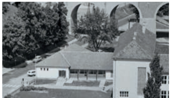
Direktorswohnung und Festsaal (I.) werden für die Sonderschule umgestaltet.
