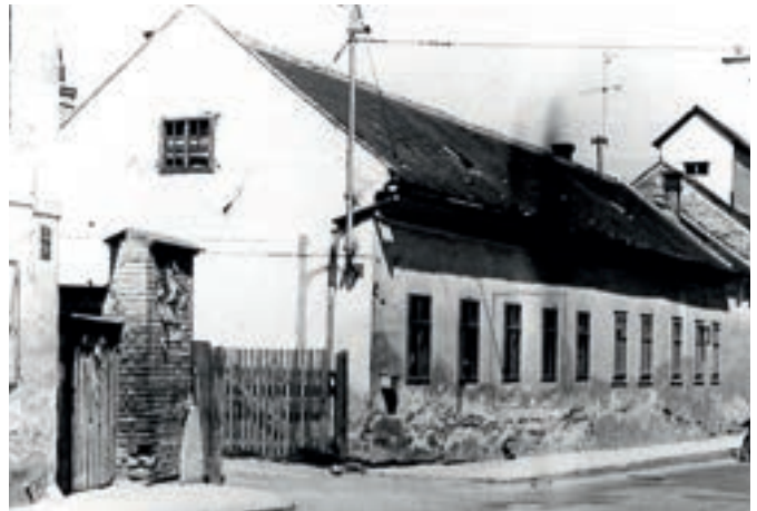
Gebäude der Straßenverwaltung
