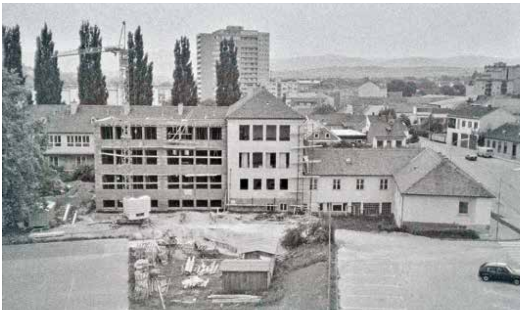
1984, Bauarbeiten für die HAK (Foto Werner Prünner)
