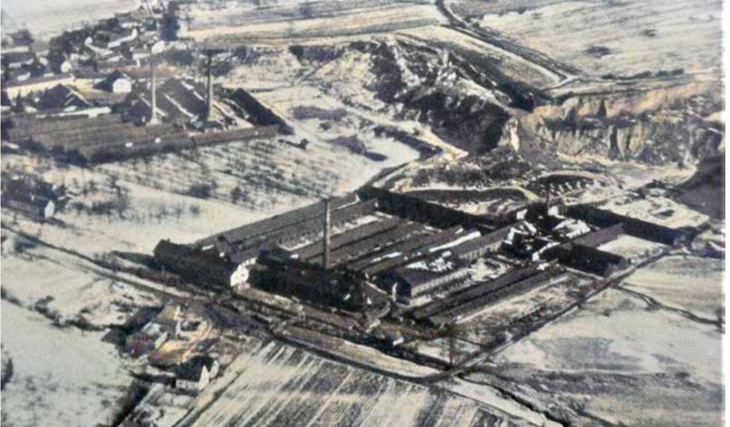
Die beiden Walbersdorfer Ziegelöfen mit den Lehmwänden
