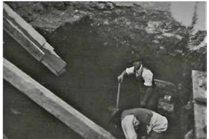
Neubau des Postamtes in Mattersburg 1928
